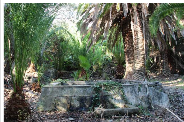
Vista 11 - Vista della vasca ornamentale da recuperare
