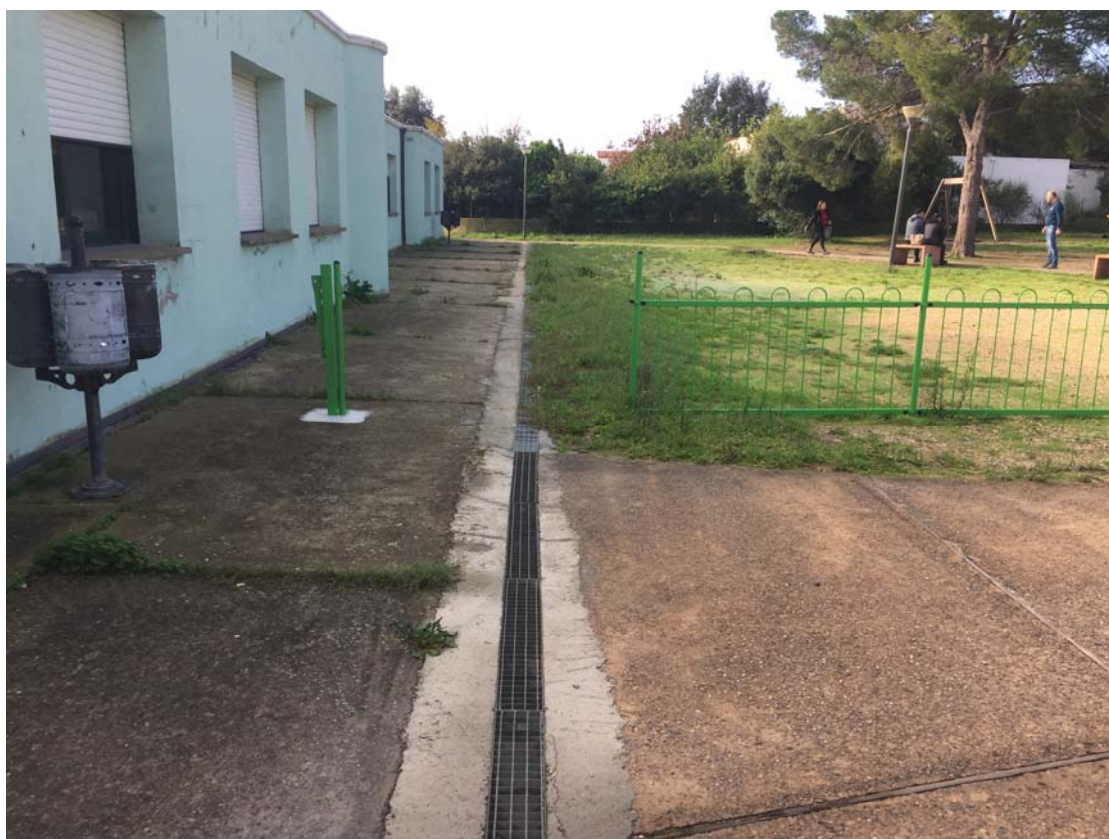
Foto 4 Caditoia e Facciata esterna oggetto di intervento.
