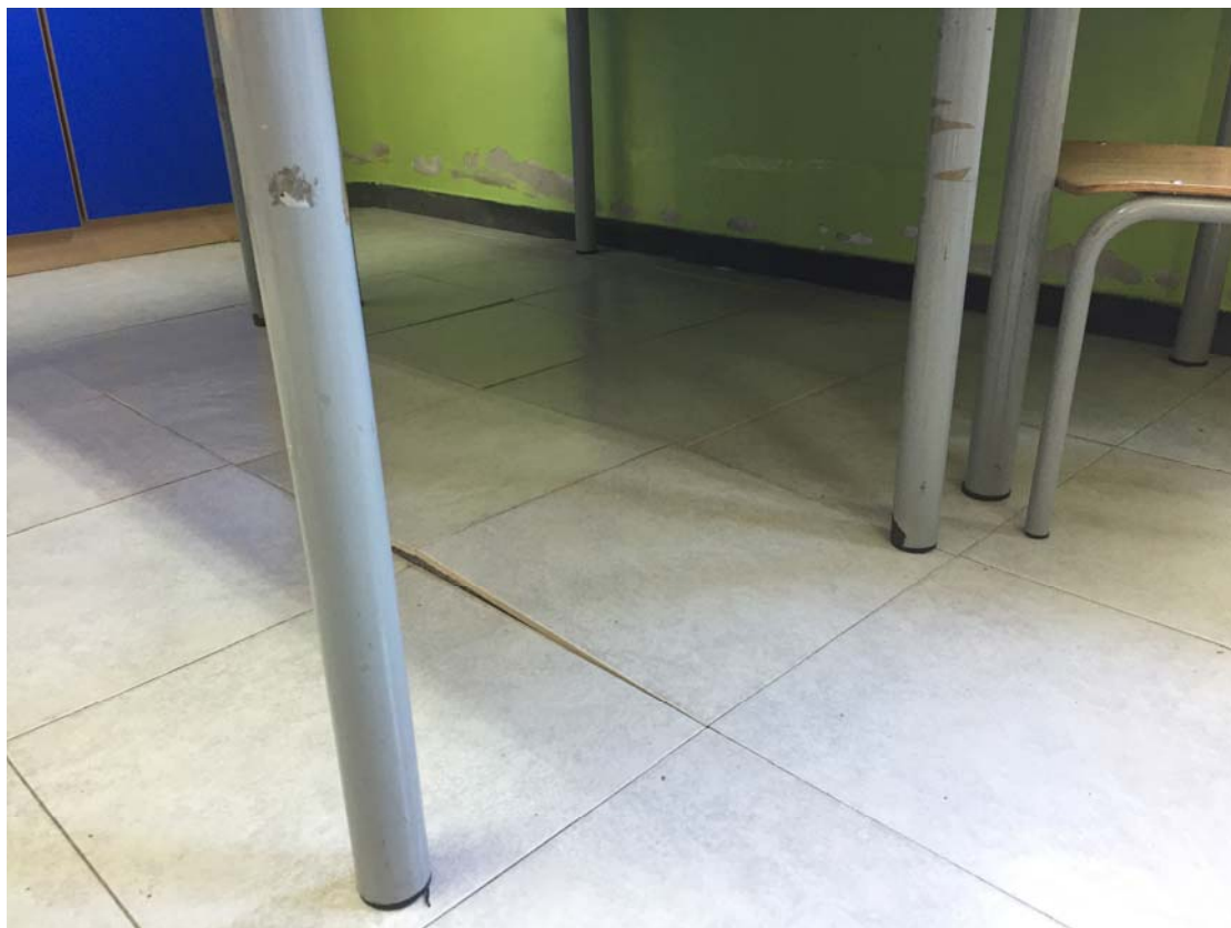
Foto 7 Rimozione di pavimento
