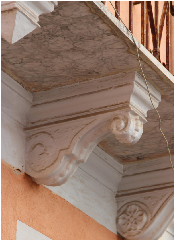
Mensola con voluta Quella rappresentata nella fotografia è una delle mensole decorate più comuni; generalmente si trova, nei balconi, in posizione centrale.
