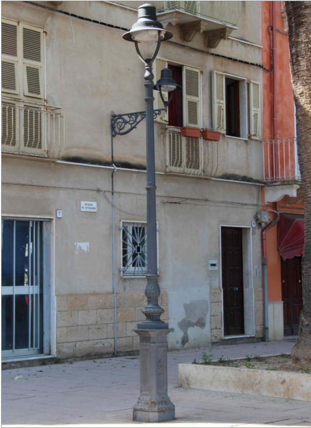
Lampioni Questi elementi per l'illuminazione pubblica sono costituiti da pali in ghisa di diverse altezze; il corpo illuminante è stato recentemente sostituito con un gruppo ottico a led.
