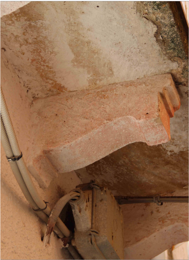
Mensola in pietra Questo tipo rappresenta delle mensole in pietra con una semplice modellazione.
