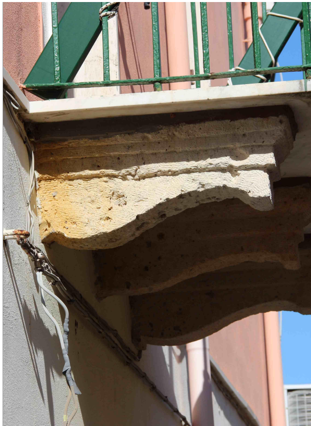
Mensola in pietra Questo tipo rappresenta una delle mensole più antiche, costituite da un unico blocco di pietra decorato.
