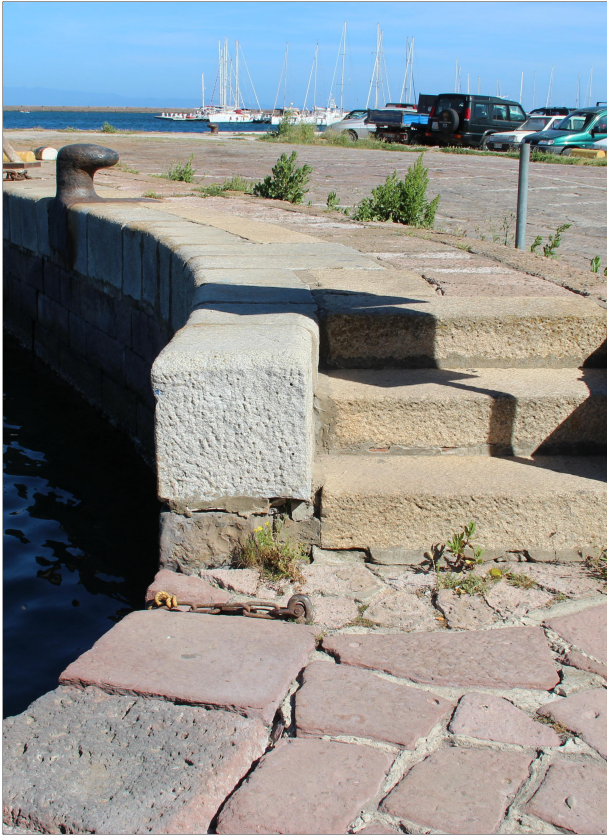
Banchina storica La banchina storica è quella ancora presente in un tratto di lungomare compreso tra la via Roma e la via XX Settembre. La pavimentazione è costituita da pietre di colore rosso (trachite), lasciate faccia a vista. Le fughe tra un blocco di pietra e l'altro sono riempite con malta di calce. Le pietre provengono dalla cava di La Maddalena, e la banchina è stata realizzata ai primi del '900.
