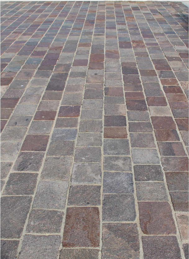
Pavimentazione Spazi pubblici Questa pavimentazione in lastre di porfido argentino è la più diffusa in tutti gli spazi pubblici di dimensioni ridotte e in tutti i marciapiedi. Questo tipo di pavimentazione è frutto di interventi sparsi di pavimentazione degli spazi aperti avvenuti tra gli anni '80 e '90.
