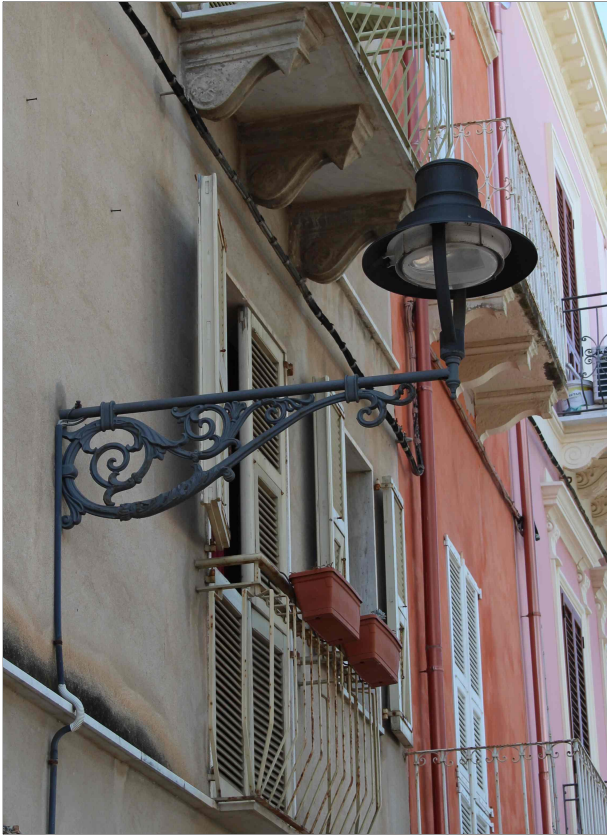
Corpi illuminanti a parete Questi elementi per l'illuminazione pubblica a parete, sono in ghisa, posizionati a diverse altezze; il corpo illuminante è stato recentemente sostituito con un gruppo ottico a led.
