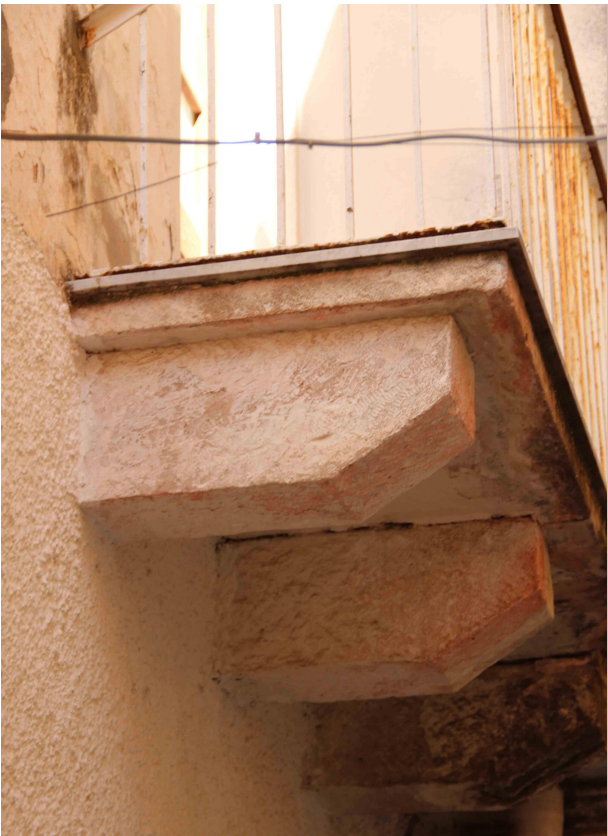
Mensola in pietra Questo tipo rappresenta una delle mensole più antiche ,costituite da un unico blocco di pietra appena sbozzato e non decorato.
