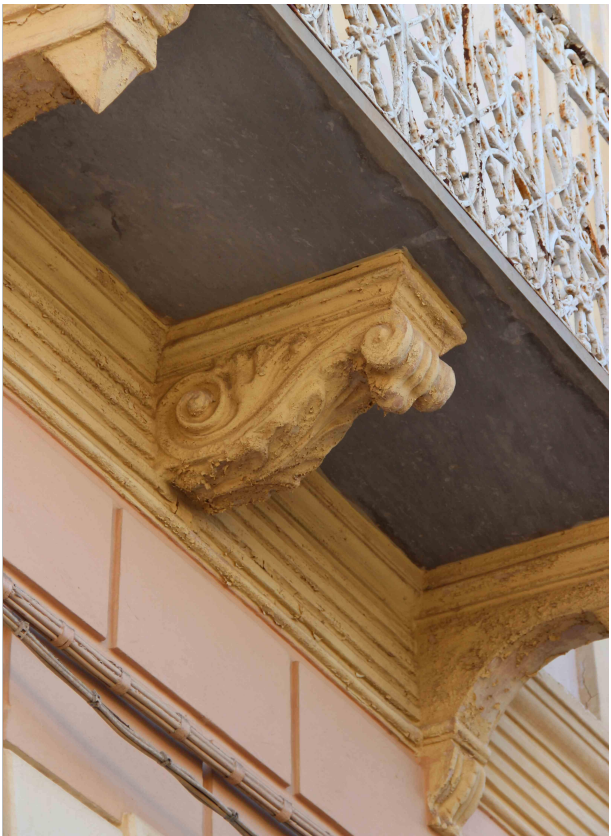
Mensola con voluta Questo tipo rappresenta una delle mensole decorate con voluta; generalmente si trova nei balconi in posizione centrale.
