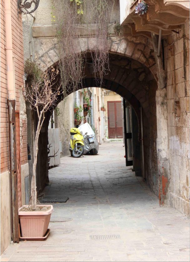
Arco di Via Dante Questo arco è un passaggio localizzato al disotto di un edificio; è costituito da una volta a botte in pietra che rimane faccia a vista.
