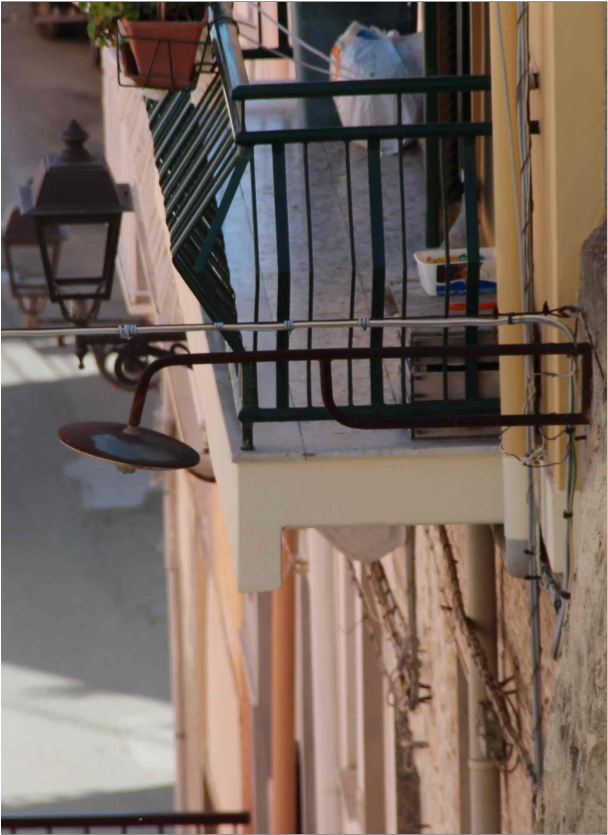
Corpi illuminanti a parete Questi elementi per l'illuminazione pubblica a parete, sono in ghisa, posizionati a diverse altezze; il corpo illuminante è stato recentemente sostituito con un gruppo ottico a led.
