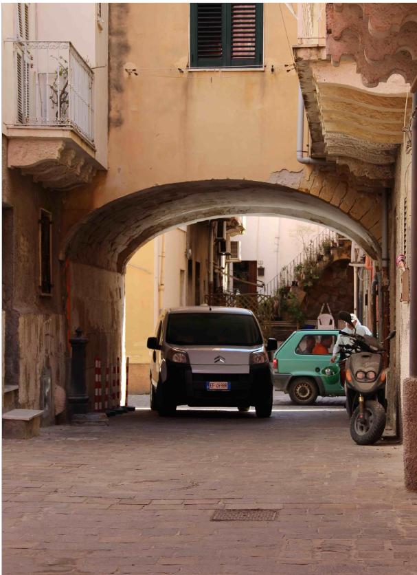
Arco di Vico Napoli Questo arco è un passaggio al disotto di un edificio, realizzato per mezzo di una volta ribassata in pietra che rimane faccia a vista.
