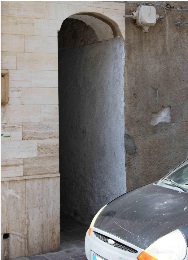
Arco di via Monteponi Questo passaggio presenta un ingresso ad arco mentre all'interno è coperto da un solaio piano; la facciata non è più rifinita con il materiale originale costituito da intonaco a base di calce. E' invece presente un rivestimento in marmo.
