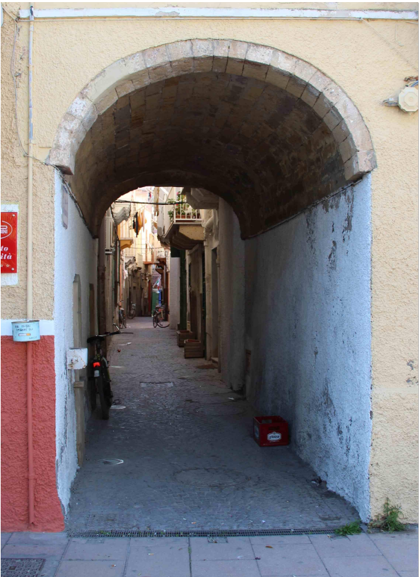
Arco di vico Carlo Emanuele Questo arco è l'accesso a un "carruggio" che dalla piazza del lungomare conduce sia alla via XX Settembre che alla piazza Repubblica. L'arco è in pietra faccia a vista, così come la volta a botte retrostante.
