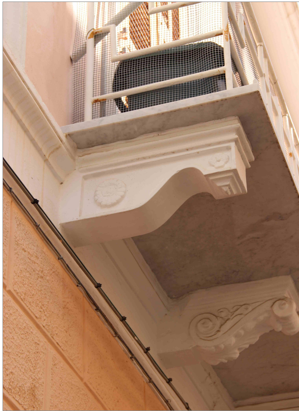
Mensola decorata Questo tipo rappresenta una delle mensole decorate più comuni; generalmente si trova nei balconi in posizione laterale.
