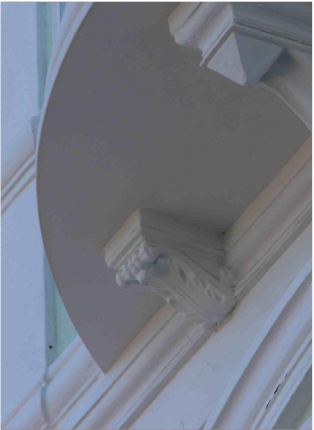
Mensola corta Quella rappresentata nella fotografia è una delle mensole corte che ha funzione solo decorativa e non è portante; generalmente si trova a sostegno dei balconi semicirculari, in posizione laterale.
