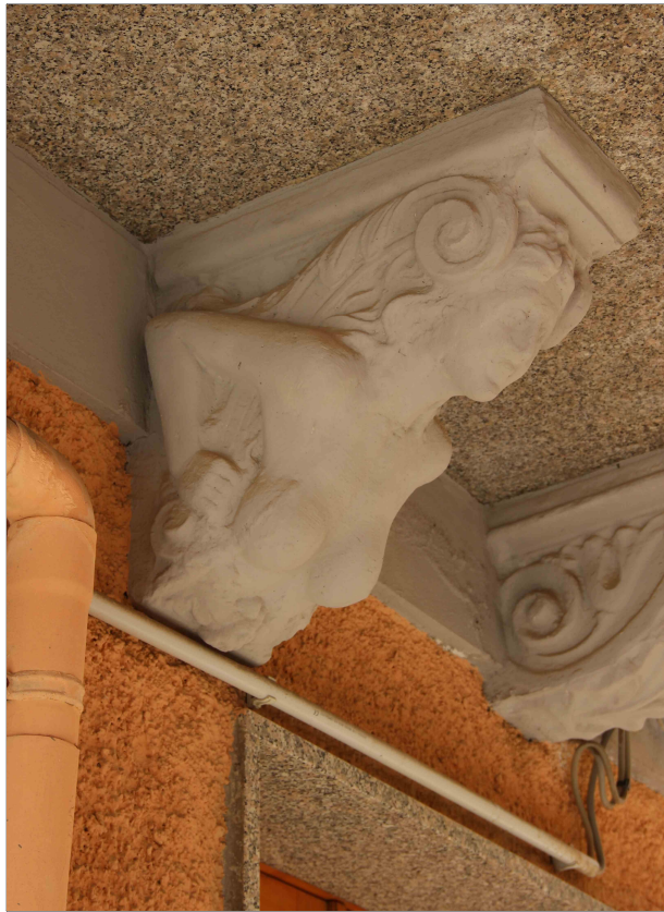
Mensola decorata Questo tipo rappresenta una delle mensole decorate più complesse; generalmente si trova nei balconi in posizione centrale.
