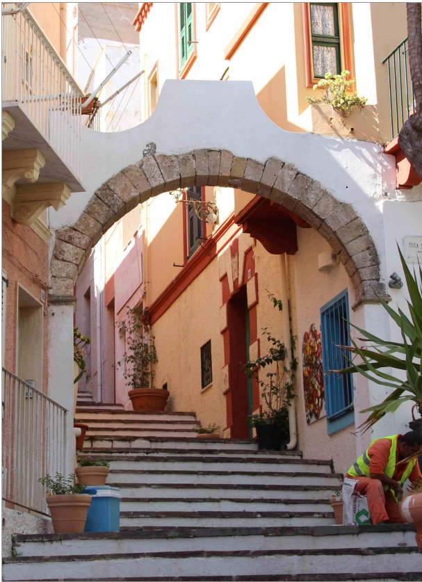
Arco di via Solferino Questo arco si presenta con una finitura intonacata e tinteggiata in colore bianco; gli elementi strutturali in materiale lapideo costituenti l'arco vero e proprio sono in pietra faccia a vista.
