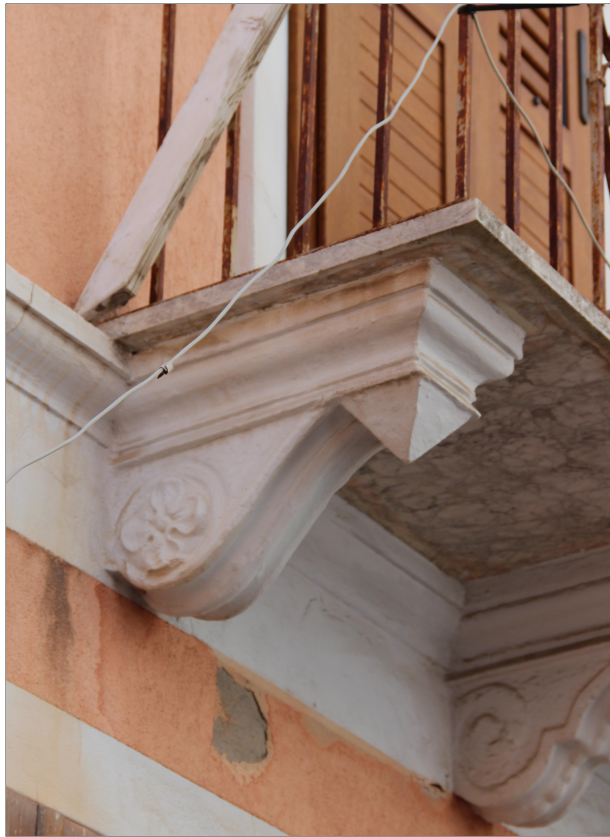
Mensola decorata Quella rappresentata nella fotografia è una delle mensole decorate più comuni; generalmente si trova, nei balconi, in posizione laterale.
