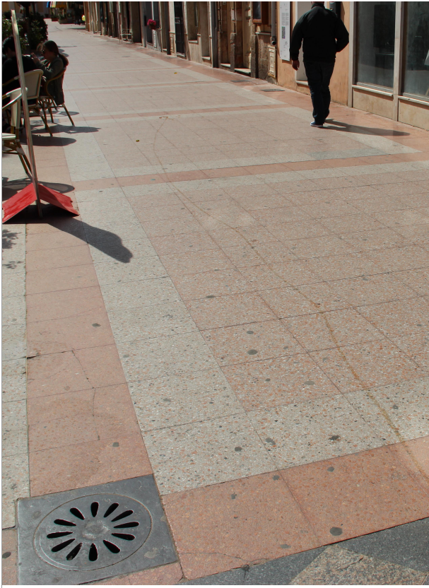
Pavimentazione Piazza Repubblica Questa pavimentazione in piastrelle rosse e bianche ricopre tutta la superficie della piazza Repubblica, del corso Tagliafico e di grandi porzioni del lungomare lato abitazioni. Questa pavimentazione è presente dagli anni '50; ha subito numerose trasformazioni a seguito di interventi di sostituzione delle piastrelle originali con altre di produzione recente che, purtroppo, non ricordano neanche lontanamente l'estetica di quelle originali.
